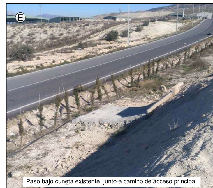
Fotografía de paso bajo cuneta existente
