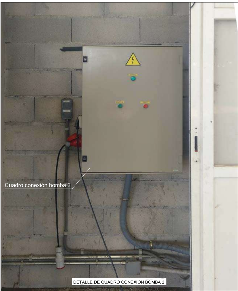
DETALLE DE CUADRO CONEXIÓN BOMBA 2
