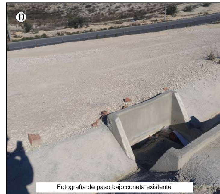
Fotografía de cuneta, prevista la colocación de P.V.C. Ø 63mm
