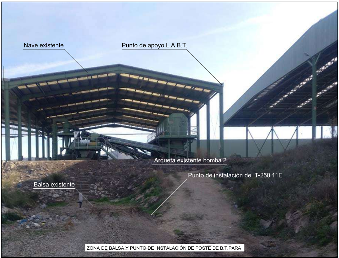
ZONA DE BALSA Y PUNTO DE INSTALACIÓN DE POSTE DE B.T. PARA BOMBA 2
